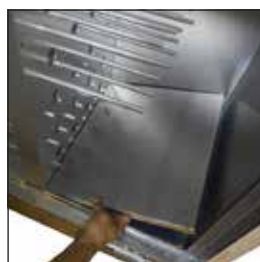
A3. Remover los paneles de acabado en aluminio
